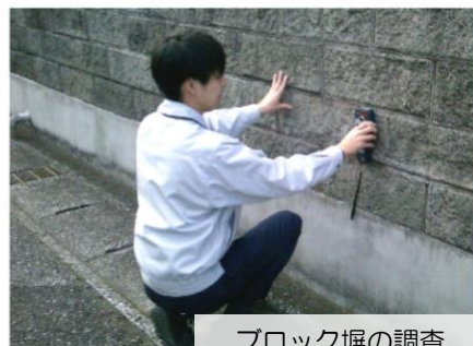
ブロック塀の調査
