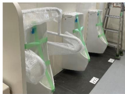
畑沢小学校校舎トイレ改修工事
