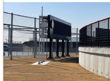
江川総合運動場拡張整備 （野球場）施設整備工事
