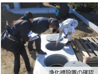
浄化槽設置の確認
