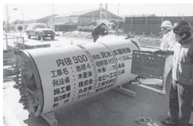
推進工法による管渠布設工事
