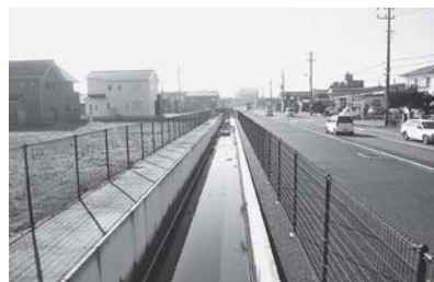
U型水路による排水路整備
