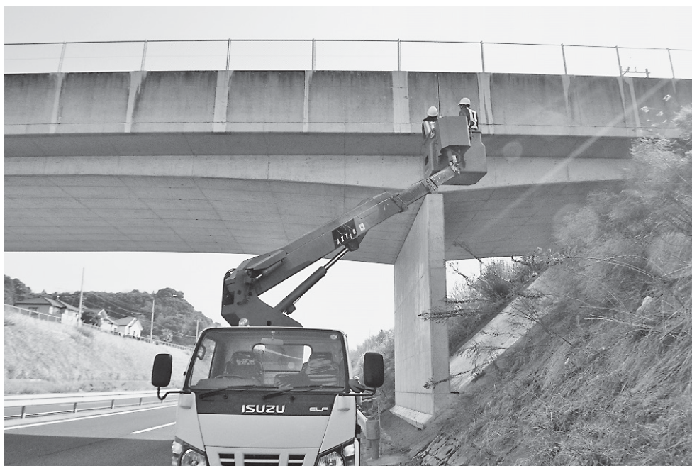
高所作業車による橋梁点検
