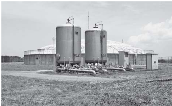
中台浄水場（請西南）
