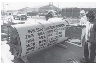
推進工法による管渠布設工事
