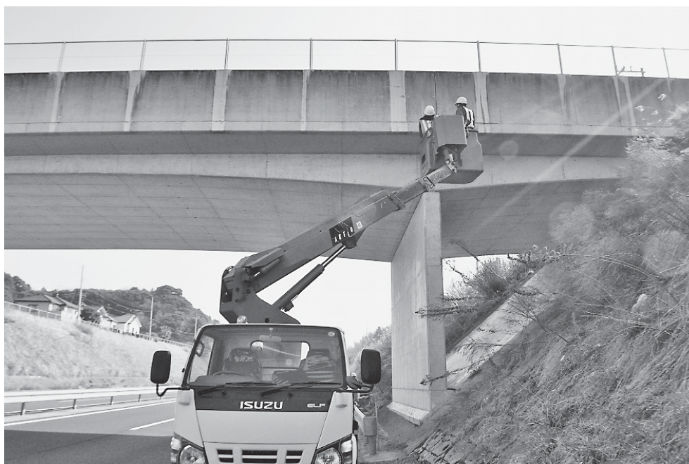
高所作業車による橋梁点検
