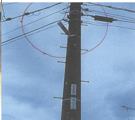
防犯灯の設置 (吾妻区)
