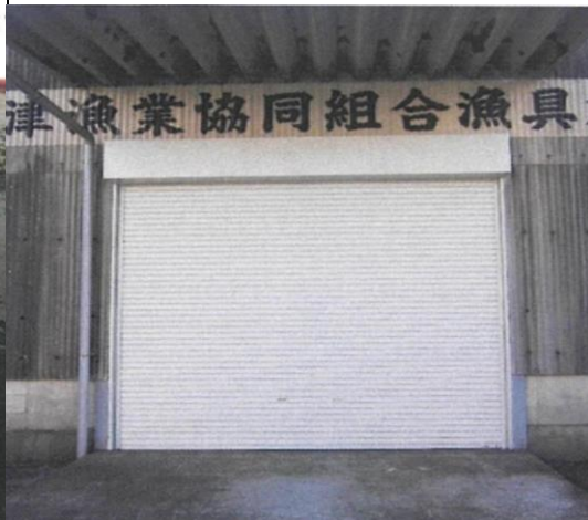
シャッター更新工事 (新木更津市漁業協同組合 木更津本所)
