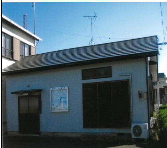
自治会管理の施設(集会場)の屋根及び外壁塗装工 事(中里2丁目区)
