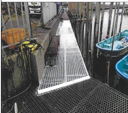
係船桟橋の改修工事 (新木更津市漁業協同組合 木更津本所)
