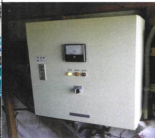
漁港内施設(制御盤)の交換工事 (新木更津市漁業協同組合 岩根支所)
