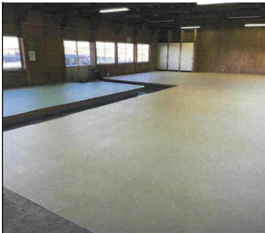
潮干狩り場施設(休憩所)の改修工事 (新木更津市漁業協同組合 牛込支所)
