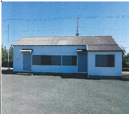
潮干狩り場施設(休憩所)の外壁工事等 (新木更津市漁業協同組合 岩根支所)
