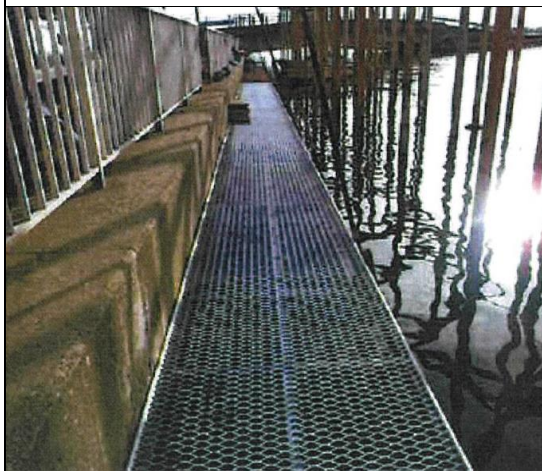
係船桟橋改修工事 (新木更津市漁業協同組合 木更津本所)
