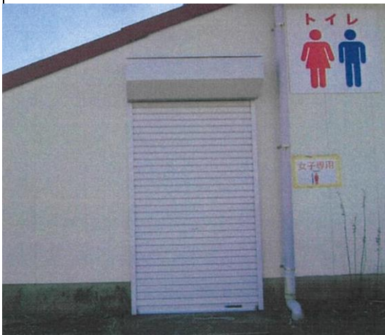
潮干狩り場施設(休憩所)のシャッター交換工事 (新木更津市漁業協同組合 牛込支所)
