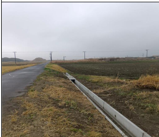
自治会管理の農業用水路のU字溝設置工事 (久津間区)
