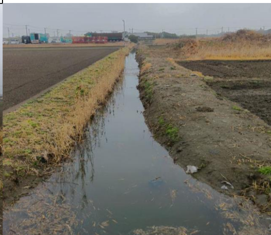
自治会管理の用排水路の汚泥撤去工事 (久津間区)
