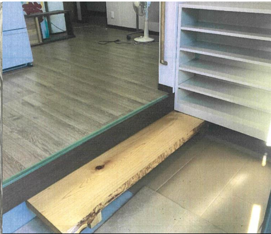
自治会管理の施設(集会場)の改修 (中里1丁目区)
