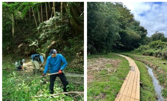
木道周辺の倒木片付け作業と修繕を行った木道
