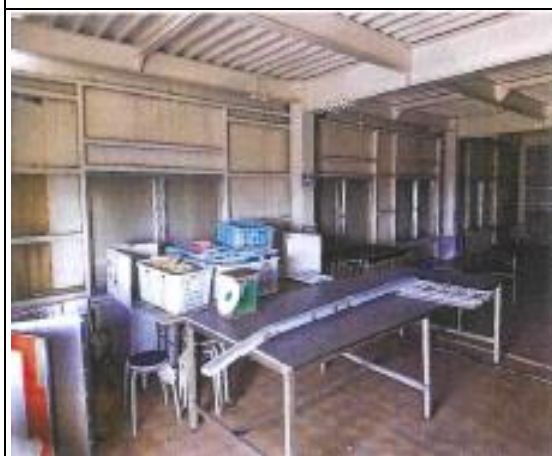
潮干狩り休憩所(外壁等)修繕 施行前② (新木更津市漁業協同組合 木更津本所)
