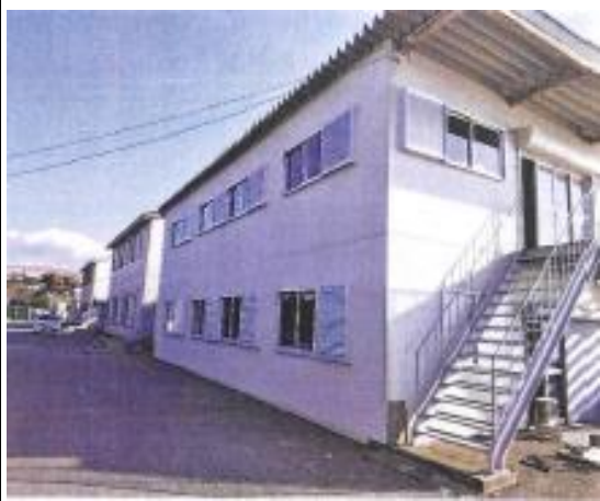
潮干狩り休憩所(外壁等)修繕 施行後① (新木更津市漁業協同組合 木更津本所)
