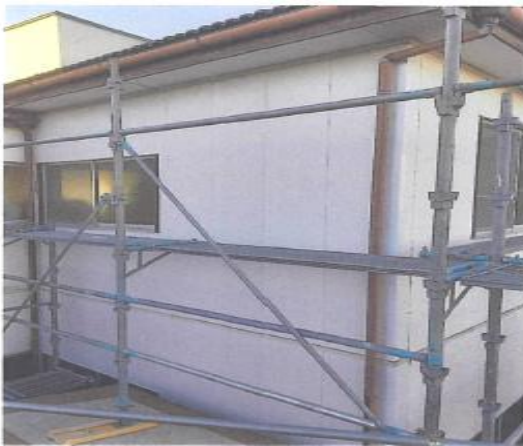
既設外壁撤去:防水シート、下地取付完了(新宿区)
