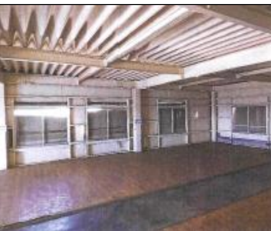
潮干狩り休憩所(外壁等)修繕 施行前③ (新木更津市漁業協同組合 木更津本所)
