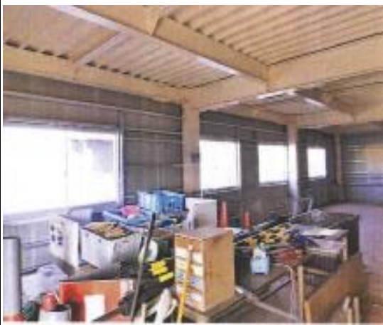
潮干狩り休憩所(外壁等)修繕 施行後② (新木更津市漁業協同組合 木更津本所)
