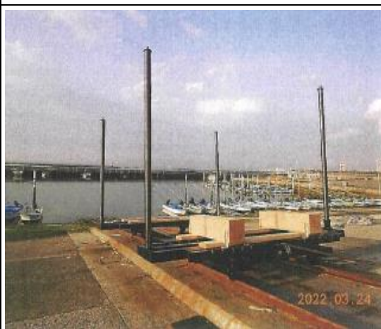
上架用台車製作工事 施行後② (新木更津市漁業協同組合 牛込支所)
