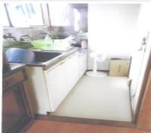
流し台補修(新宿区)
