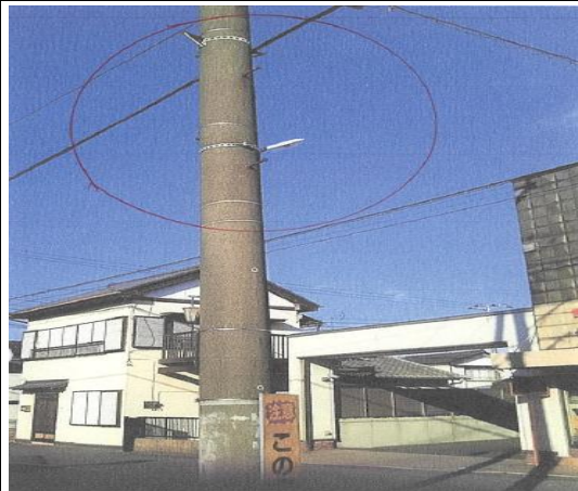
防犯灯設置①(吾妻区)
