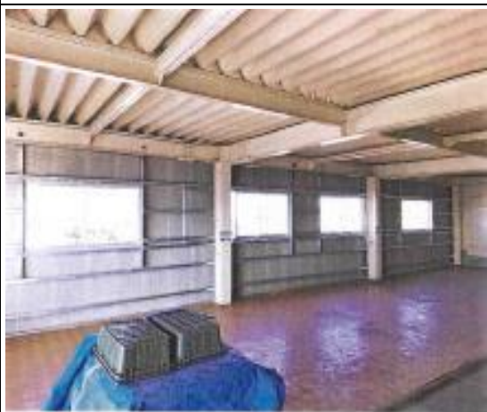
潮干狩り休憩所(外壁等)修繕 施行後③ (新木更津市漁業協同組合 木更津本所)
