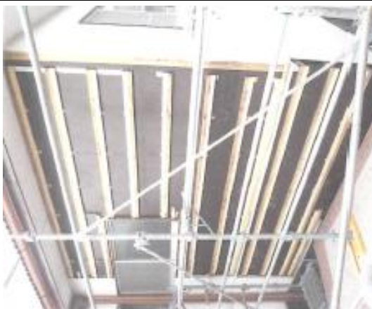
既設外壁撤去:防水シート、下地取付②(新宿区)
