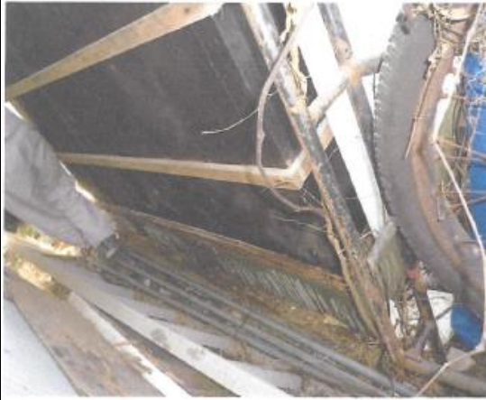
既設外壁撤去:防水シート、下地取付④(新宿区)
