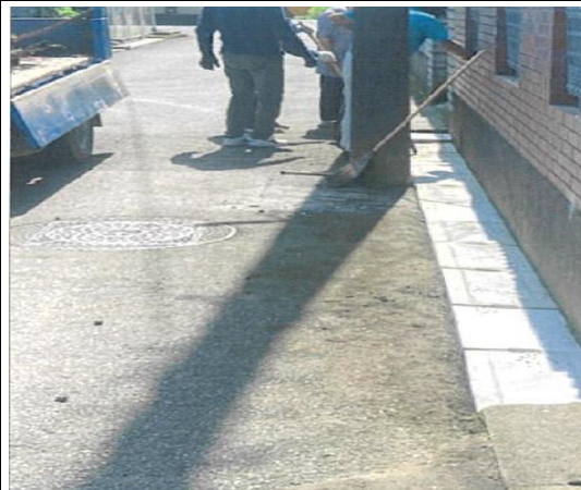
側溝工事(中里1丁目区)
