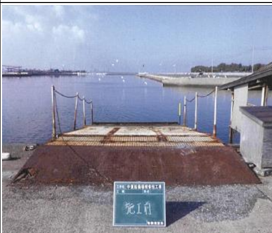
船揚げ場等補修 施行前① (新木更津市漁業協同組合 木更津本所)
