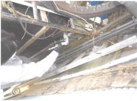
既設外壁撤去:防水シート、下地取付③(新宿区)
