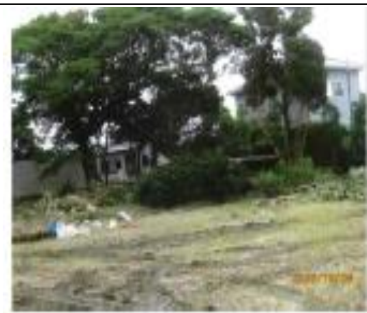
神明神社 境内樹木の伐採、枝つめ工事① (中里2丁目区)
