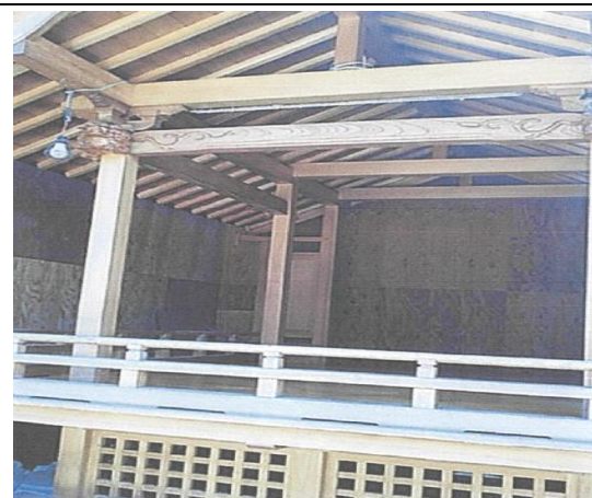
獅子台塗装工事(吾妻区)
