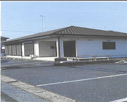
吾妻区公会堂外壁塗装工事(吾妻区)
