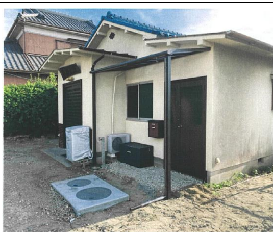
集会場の改修:倉庫修理、浄化槽設置等 (中里1丁目区)
