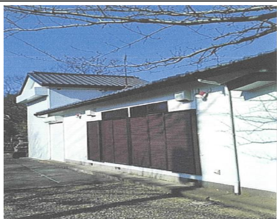
青年会議所外壁塗装工事(吾妻区)
