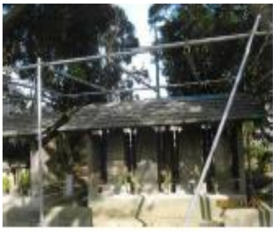
神明神社 境内樹木の伐採、枝つめ工事② (中里2丁目区)
