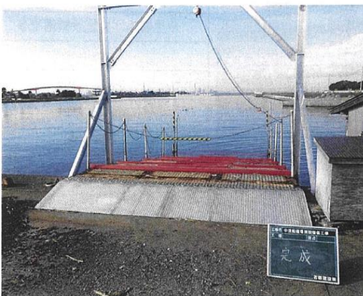
中里船揚げ場施設整備工事 (新木更津市漁業協同組合 木更津本所)
