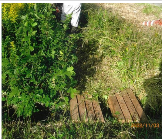
橋桁設置後：農業用水路周辺の除草資材 (中里2丁目区)
