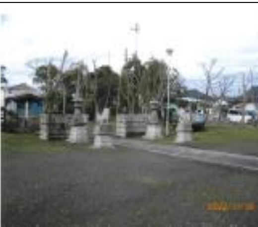
神明神社 境内樹木の伐採、枝つめ工事⑤ (中里2丁目区)
