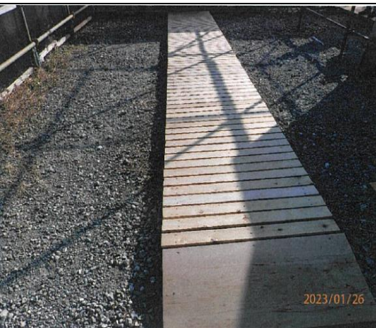
潮干狩りトイレ囲い補修 (新木更津市漁業協同組合 久津間支所)
